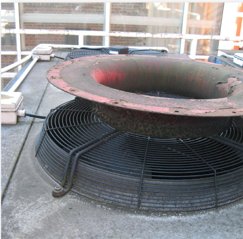
Fot. 40. E. Nakoneczny K. Kramarczyk Niesprawny skraplacz na dachu
