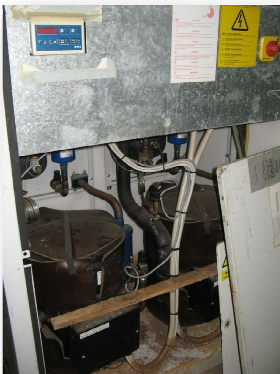
Fot. 41. E. Nakoneczny K. Kramarczyk Zdekompletowany agregat chłodniczy w pom.0/28
